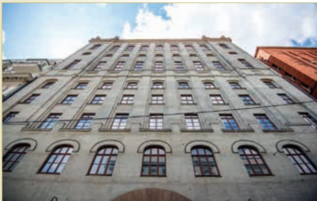
Здание Московской центральной телефонной станции Шведско-датско-русского телефонного акционерного общества в Милютинском переулке на момент постройки в начале XX века было самым высоким гражданским сооружением города
